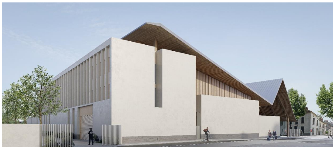
© BLP & Associés – Vue depuis la façade Nord
