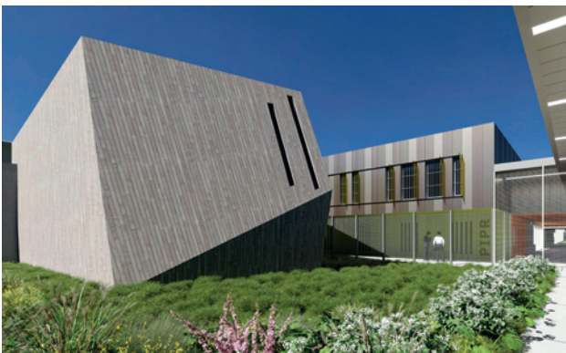
Centre pénitentiaire de Caen - IFS Vue extérieure
