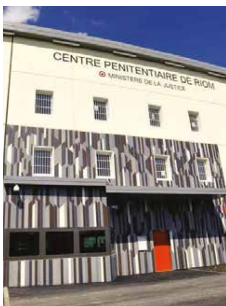
Centre pénitentiaire de Riom
