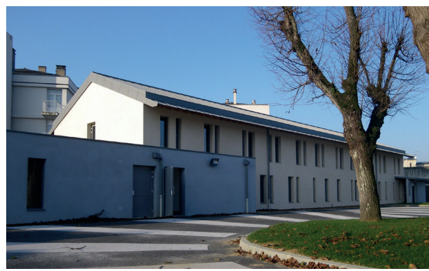
Structure d'accompagnement vers la sortie (SAS) Quartier de semi-liberté d'Angers
