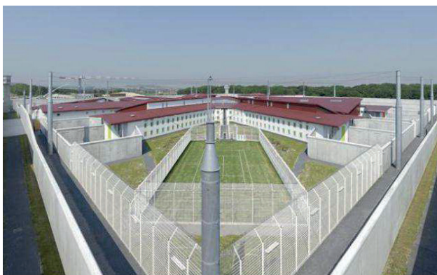
Maison centrale Centre pénitentiaire de Vendin-le-Vieil
