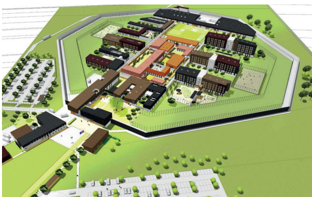
Centre pénitentiaire à sûreté adaptée Centre pénitentiaire de Lutterbach
