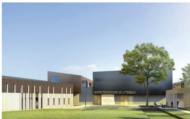
Centre pénitentiaire de Lutterbach Porte d'entrée principale
