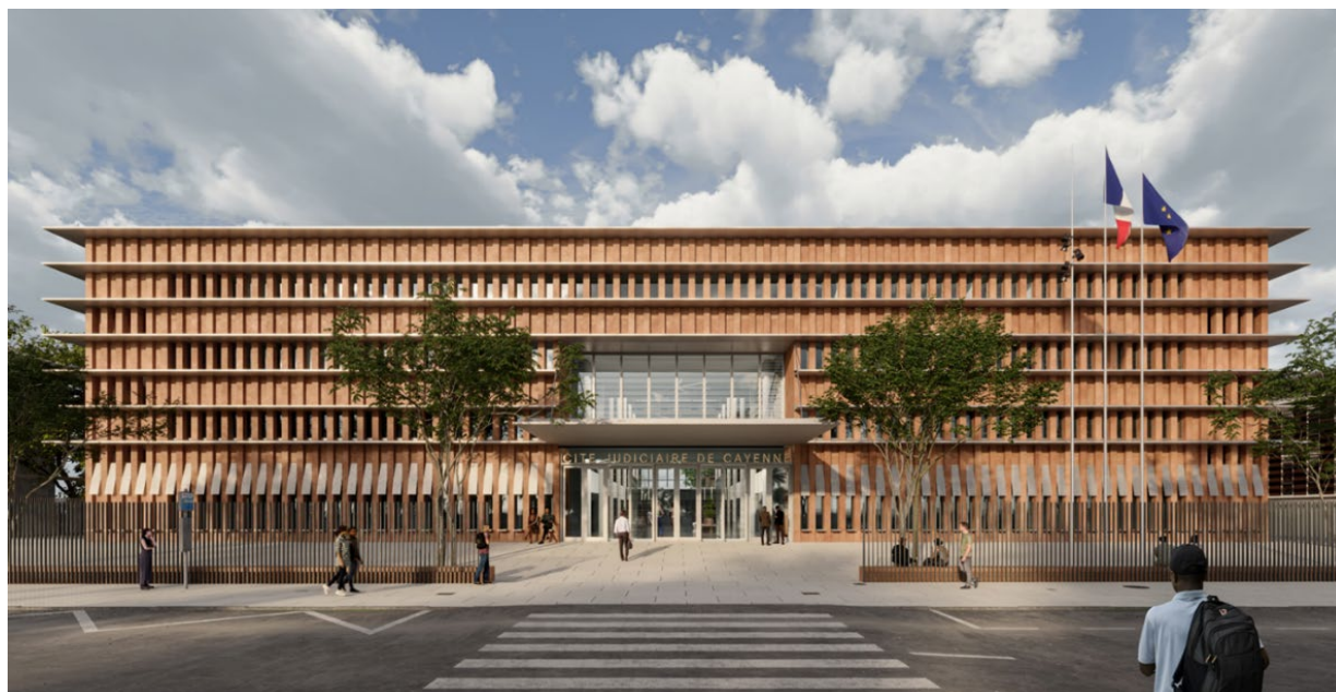
Vue de l'entrée de la cité judiciaire de Cayenne © Champenois Architecte et ACAPA Architecture
