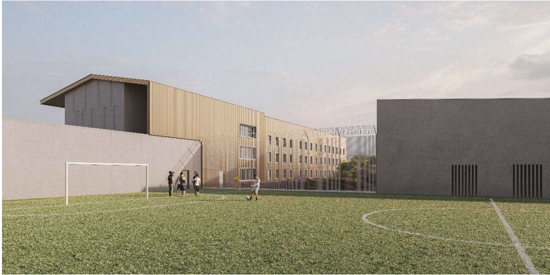
Vue depuis le Terrain de sport © AIA Architectes © WTFA/ Architectes Associés
